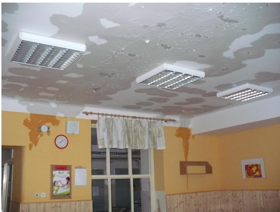
Havárie vodovodního potrubí 28. 8. 2011
